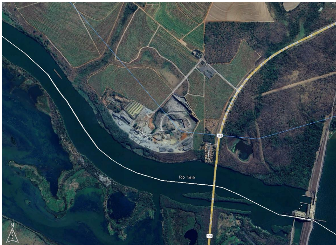
Figura 5.3-7: Presença de mineração em Ubarana às margens do Rio Tietê
